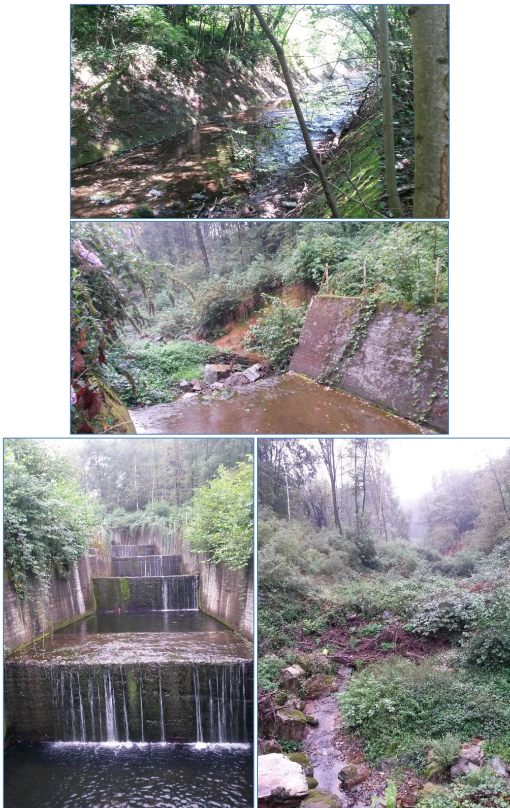
Figura 20: Sistemazione idraulica del Rio a Nord di C.se Berchera: tratti rivestiti, alternanze di briglie e vasche di decantazione, bacini di deposizione
