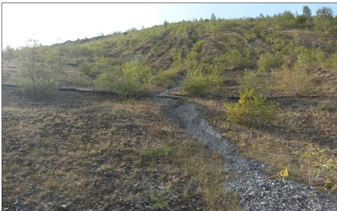
Figura 9: Solchi di erosione incanalata al piede dell'accumulo orientale (in primo piano); sullo sfondo: solchi di erosione in fase di progressivo rinverdimento (non ancora interessati da interventi di regimazione idraulica)
