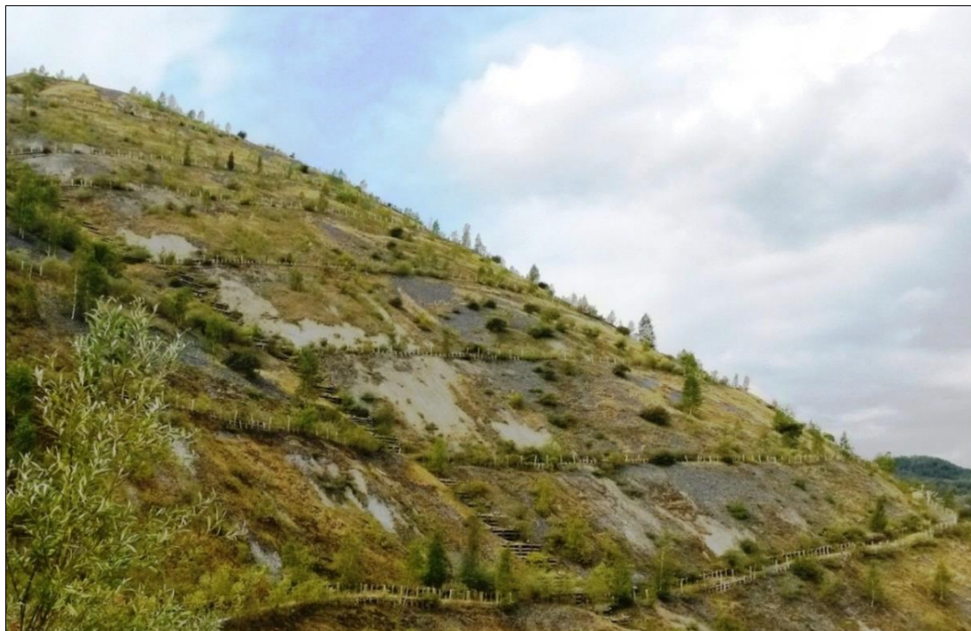
Figura 10: Superfici residue soggette ad erosione laminare diffusa (“sheet erosion”) ed eolica, in quanto prive di rinverdimento superficiale; settore intermedio dell’accumulo occidentale
