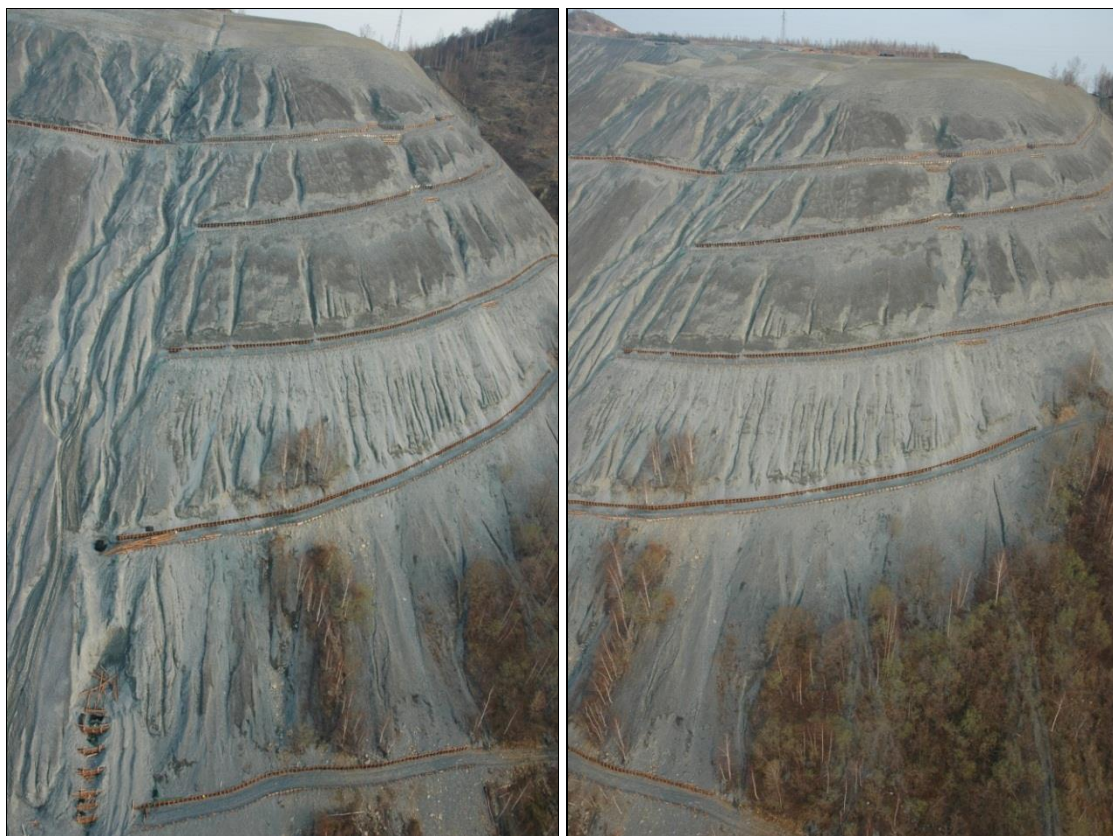
Figura 8: Dettagli che evidenziano l'interruzione dei solchi erosivi da parte dei “passi d'uomo” realizzati con la gradonatura del versante (fonte: RSA – riprese aeree a bassa quota, aprile 2005).
