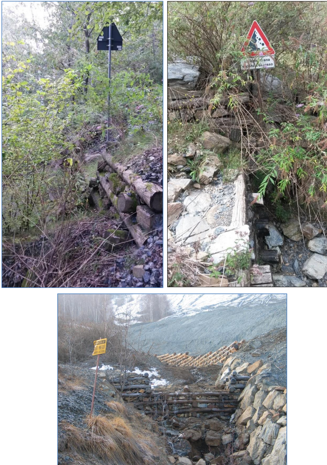
Figura 21: Sistemazioni idrauliche lungo il Rio Est, da monte verso valle; condizioni attuali delle briglie in legname e pietrame; foto in basso, relativa alla fase di costruzione, di R.S.A. (marzo 2006)
